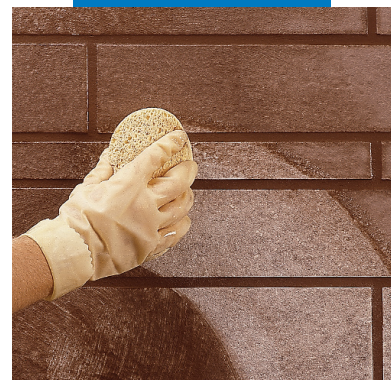
Čištění a konečná úprava spár houbou
