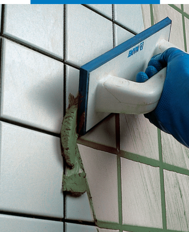
Nanášení Ultracoloru Plus gumovou stěrkou na obklad
