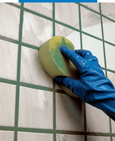
Čištění a konečná úprava obkladů houbou
